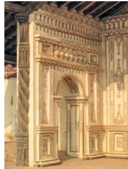
Die Kirche San Javier in Bolivien: Blick auf die Seitenwand der Vorhalle
